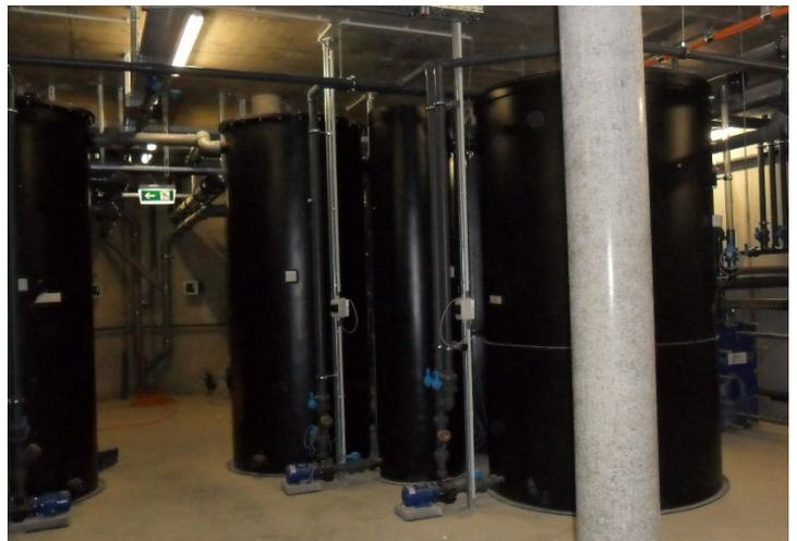
Das restliche Wasser wird zurückgewonnen und wieder der Primären Wasseraufbereitung zugeleitet. Mit dieser Verfahrenskombination wird nicht nur der Wasserbedarf niedrig gehalten sondern auch der Bedarf an neuem Salz.
