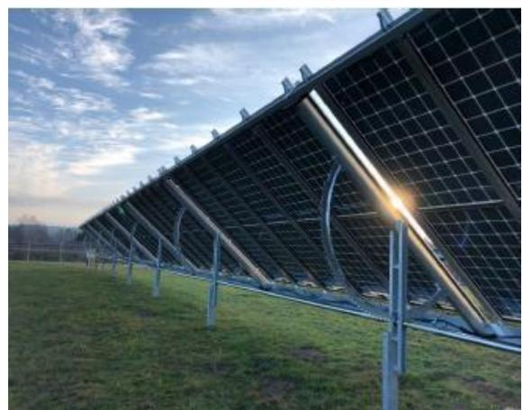
**Abbildung 2: Tracker-System mit individueller Tracker Stellung/ Verstellwinkel 60° (Quelle: FEFA PROJEKT GMBH 2022)**
