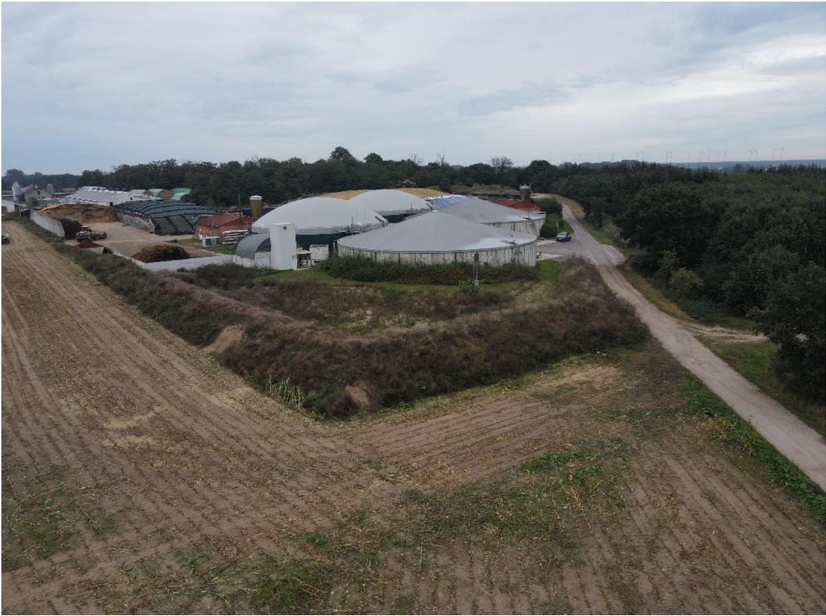
**Abbildung 2: Ansicht errichteter Wall aus Prüfbericht nach AwSV 55967581 der DEKRA vom 08.09.2022**
