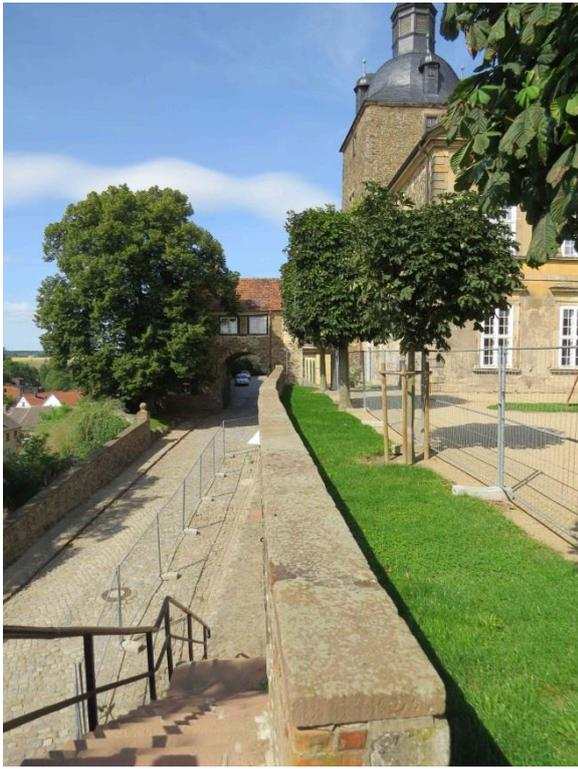
Die Stützmauer an der Schlosszufahrt im Anschluss an das Torhaus weist bis zum Ende des Treppenaufgangs eine auffällige Neigung (bis zu 50 cm) in Richtung Zufahrt auf. Wie aus einer Mörtelfuge zwischen Mauer und anschließender Fläche zwischen Schlossgebäude und Stützmauer hervorgeht, dauert die Bewegung der Mauer in Richtung Auffahrt an. Unter einem Teil des anschließenden Schlossgebäudes befindet sich eine Gruft mit darunter liegenden Gräbern.
