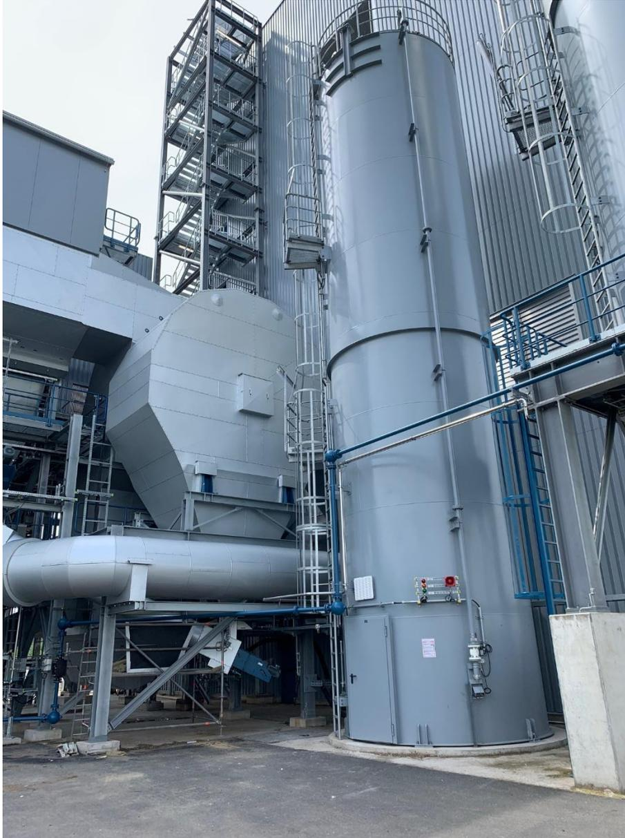
Behälter der Zuschlagsstoffe für die Rauchreinigungsanlage
