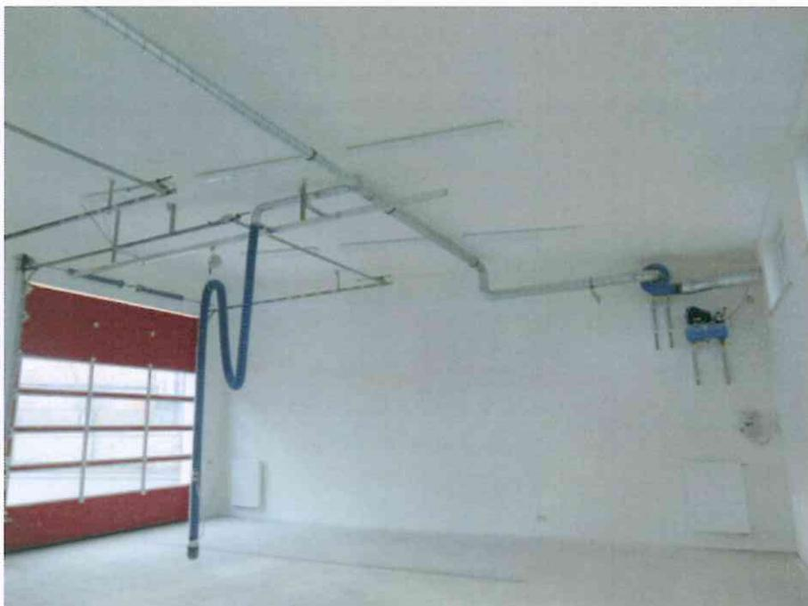
Innenansicht Fahrzeughalle mit Abgasabsauganlage
