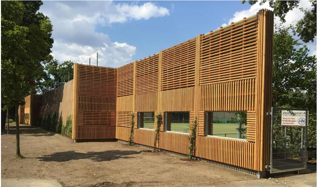
Lärmschutzwand aus Holz mit verschiedensten Gestaltungselementen - Strukturierung der Oberfläche, Einsatz von Glas und Begrünung
