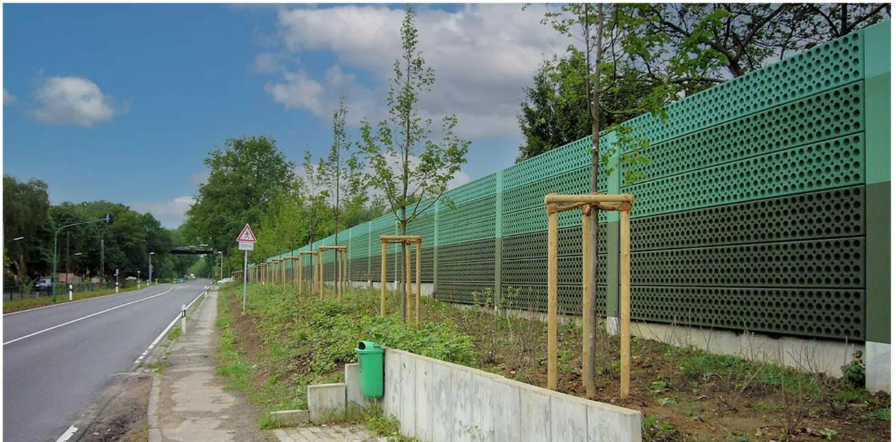
farblich und mit strukturierter Oberfläche gestalteten Lärmschutzwand aus Beton
