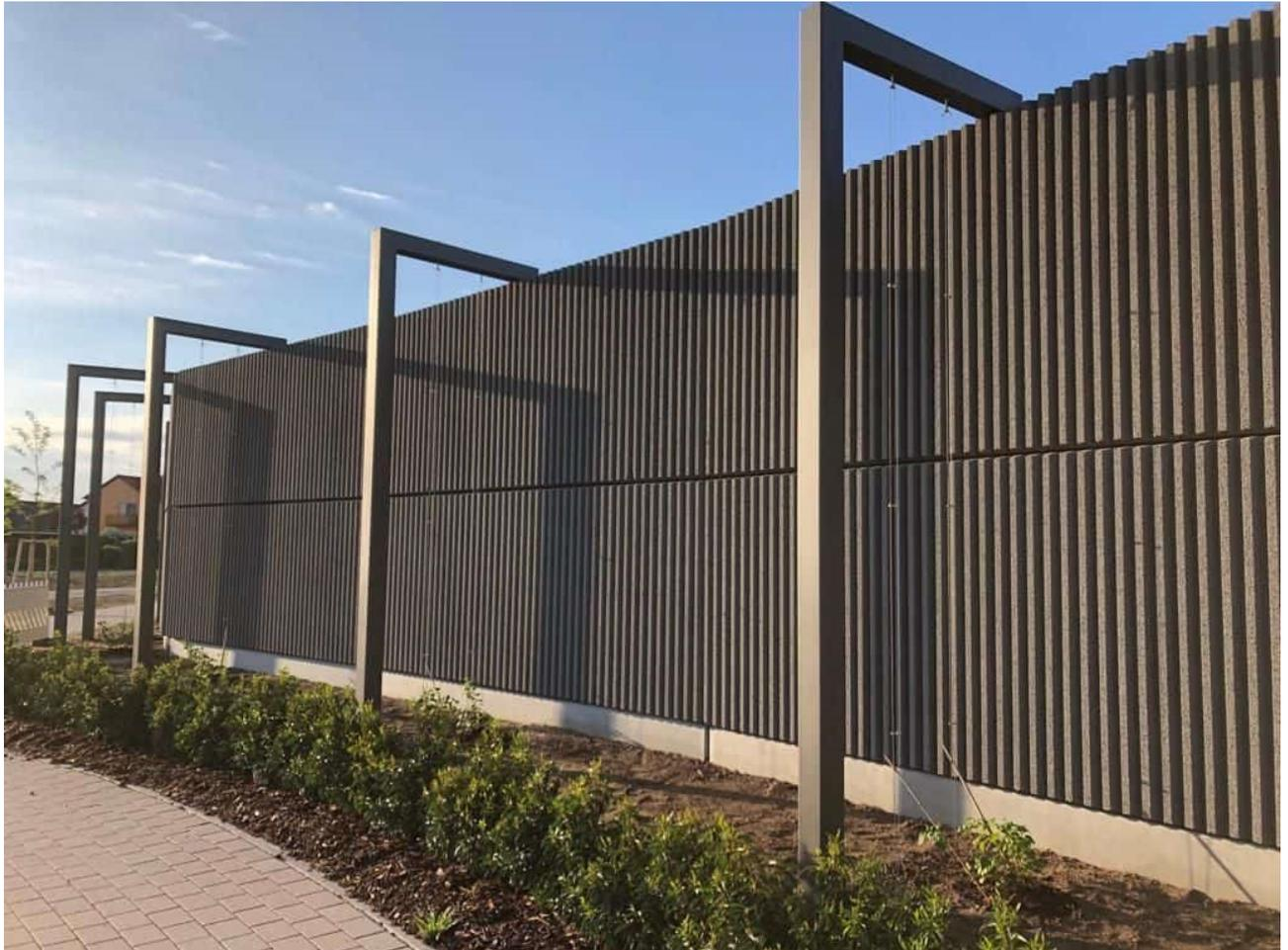
Lärmschutzwand aus Beton mit Aussteifungen und Rankhilfen
