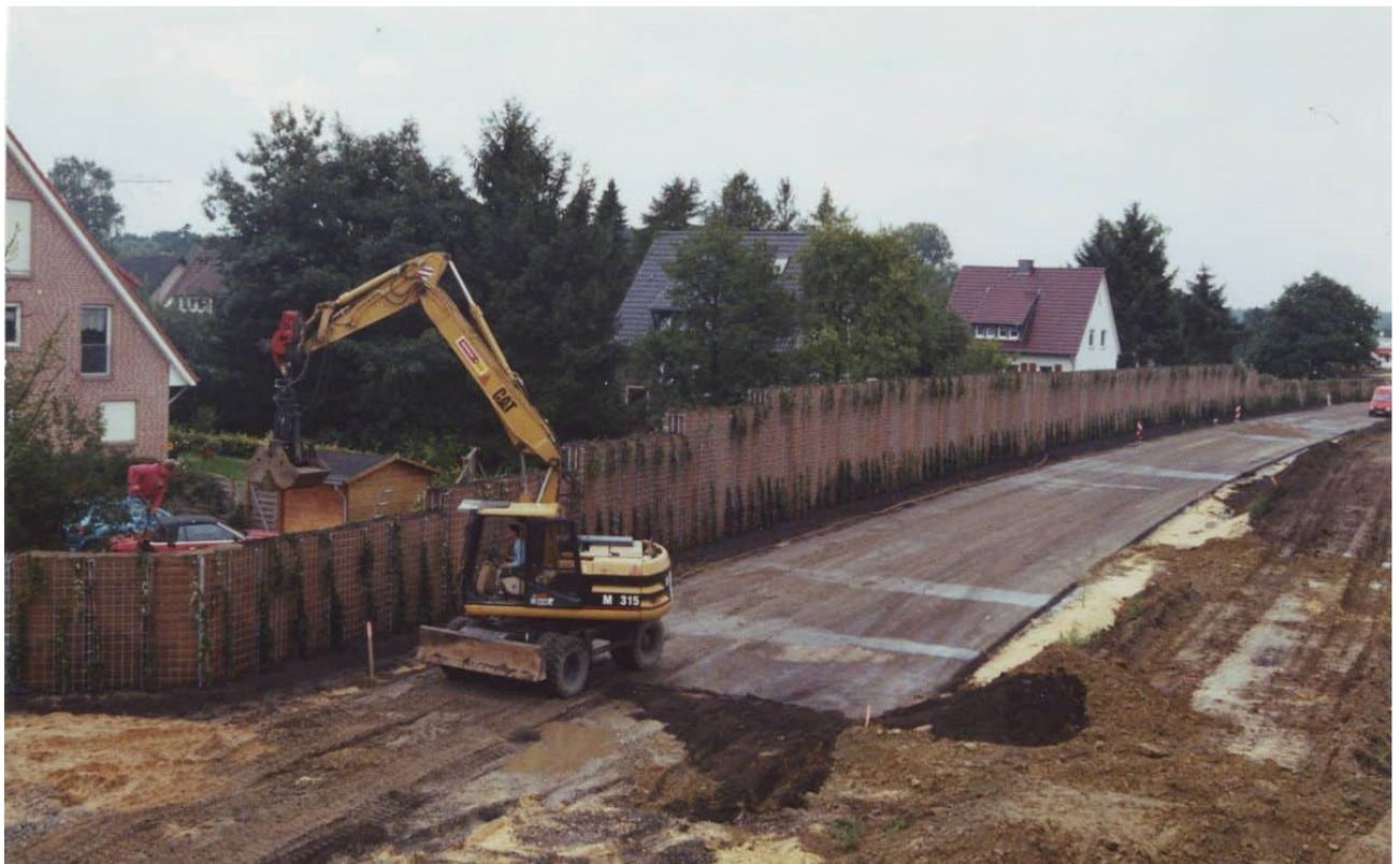
platzsparender Einbau einer Klimawand mit direktem Anschluss der Verkehrsanlage und der privaten Grundstücke
