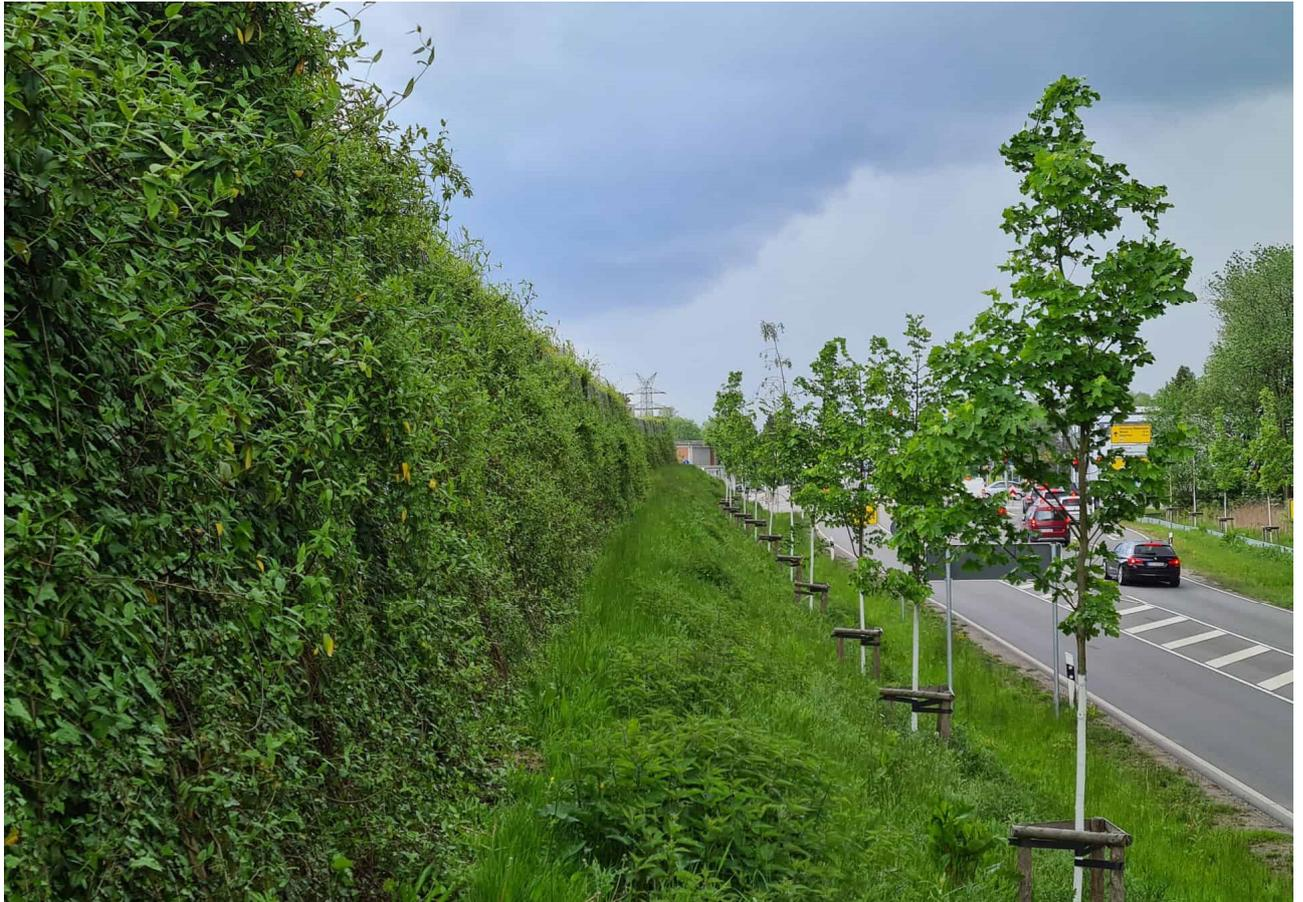
Klimawand auf halbhoher Wall mit Baumreihe am Böschungsfuß
