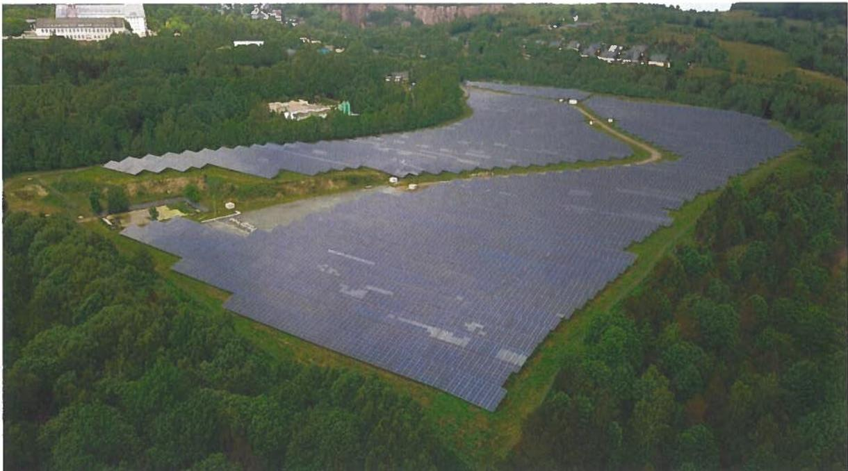
Bestandteile des Solarparks sind: Si-Solarmodule auf Zinkstahlgestellen inkl. Verkabelung und Erdung, Trafostationen, Monitoring-container, Löschwasserkissen, Wechselrichter, Batteriespeicher, Kameramasten, Rammpfosten aus verzinktem Stahl und Zaun nebst Sicherheitsüberwachungssystem sowie Wartungs- und Brandschutzwegen mit Bedarfszufahrten. Die Gründung des Solarparks erfolgt mittels Sigma Rammprofilen, die je nach Einbindetiefe in den Boden gerammt werden.
