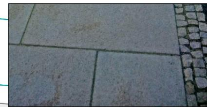
Gehwege neu mit Streifen aus großformatigem Pflaster, b = 1,80 m. Format (60 x 40 / 30 x 40 cm) und Oberfläche nach Bemusterung. Ober- und Unterstreifen aus Mosaikpflaster. Bild links: Muster Innenstadt Wernigerode
