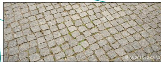
Befestigung der Fahrbahn im Abschnitt Lindenstraße bis Neustädter Platz mit neuem Kleinpflaster 10x10x10 hier: Musterfläche Notpforte Tangermünde
