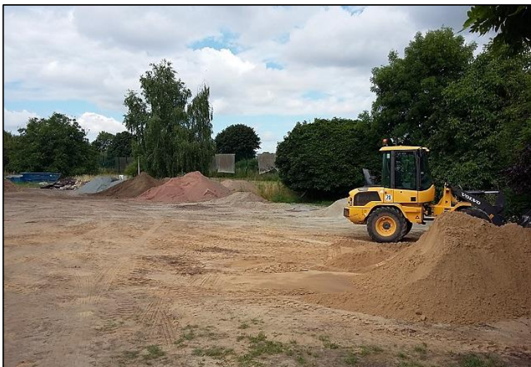
Baustofflagerplatz im zentralen Bereich
